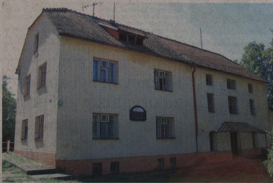
BARTKŮV MLÝN. Uvnitř se nachází funkční technologie, vzniku muzea však brání neshody mezi vlastníkem a obcí.
