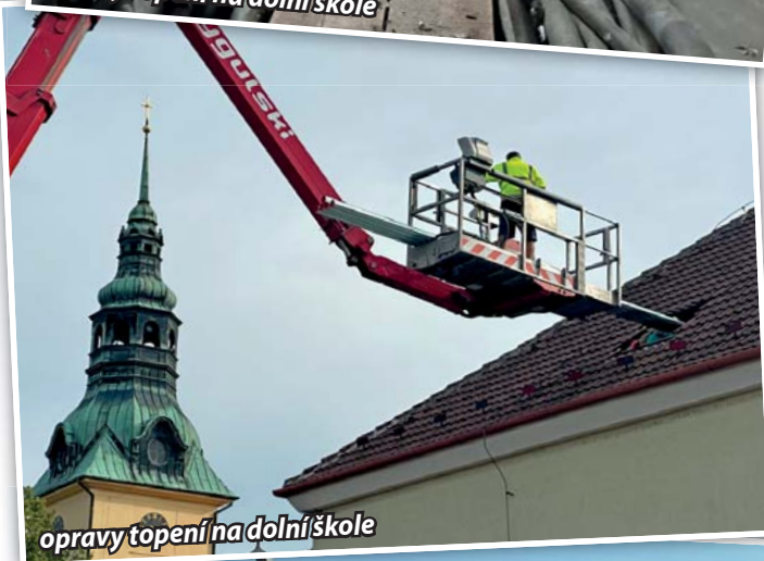
opravy topení na dolní škole
